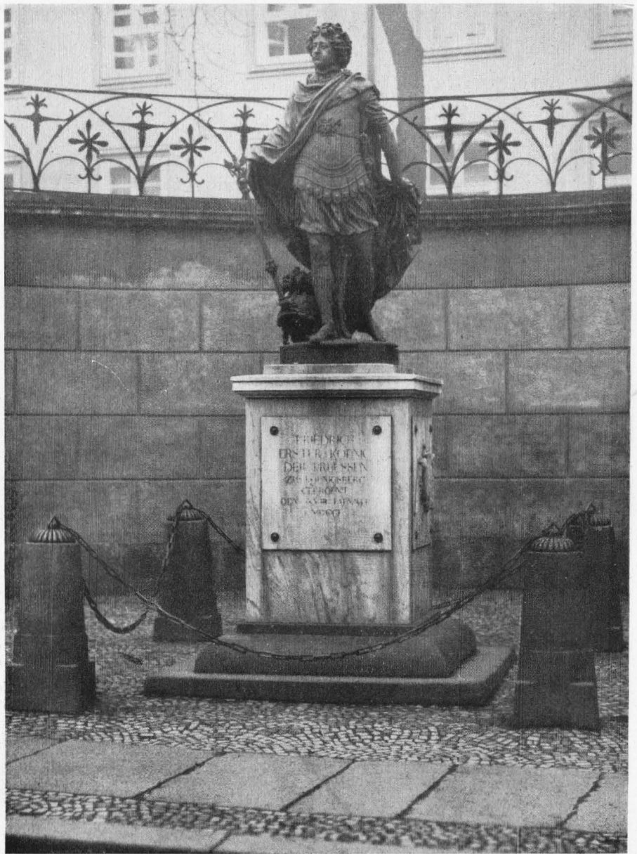
35. Denkmal Friedrichs I. von Schlüter. Umfassungsmauer von Shadow
